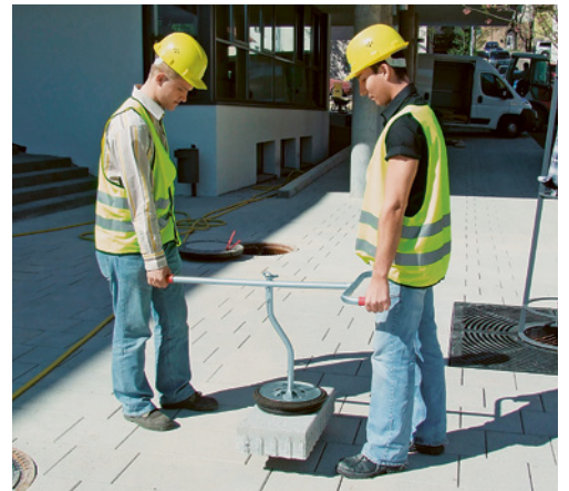
5 Vakuumheber für den Lastentransport zu zweit
